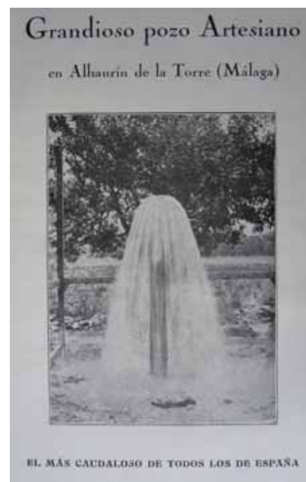
Sondeo surgente en Alhaurín de la Torre (Málaga) a principios del siglo XX. [COLECCIÓN J. BENAVENTE]
