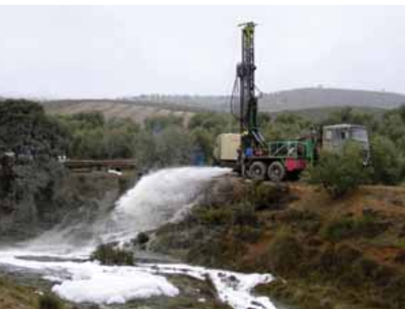
Máquina de rotoperusión perforando materiales acuíferos de las Cordilleras Béticas. [A. CASTILLO]
