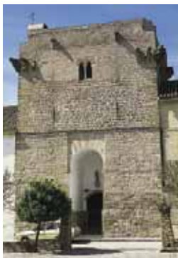
TORRE DEL CASTILLO DE CAÑETE
